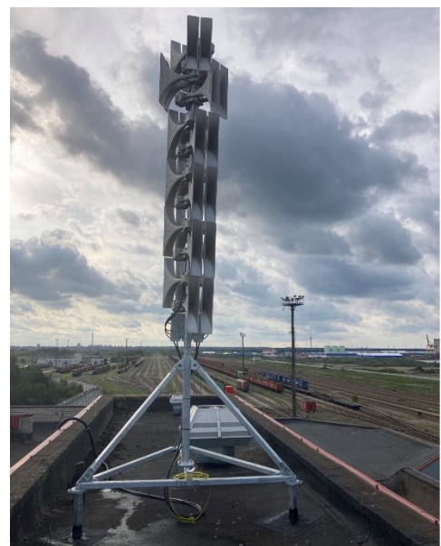
Joonis 27. Statsionaarne sireenipunkt
